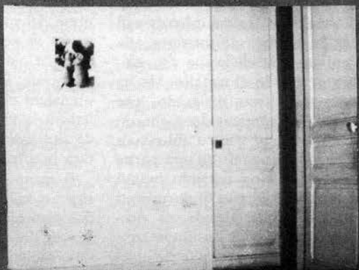
UNSE L'ENTON A LA BILLE RESTANTES DE LA ANTIETAT EN PATENTE SONT ACCROCHES AU MUR JUSQU' CEQU'EST EST PLEIN UN POSITION EN DROITE.
