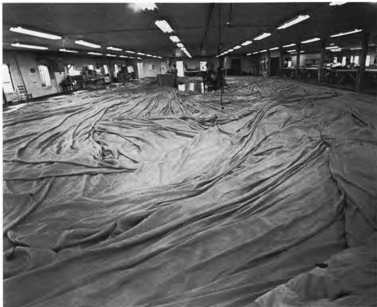
Esecuzione delle cuciture verticali per la cortina.
