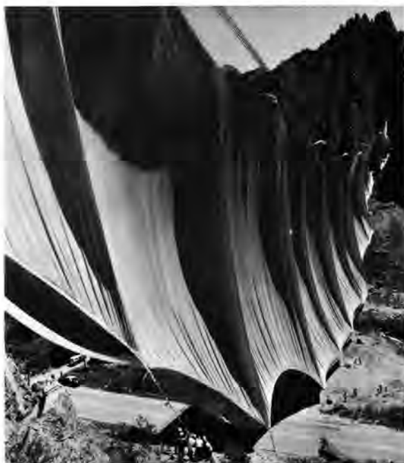
Ultimi collegamenti agli ancoraggi dei pendii.
